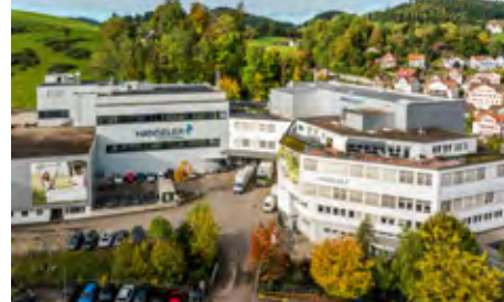
La nouvelle construction BPF de Hänse-ler SA à Herisau.
